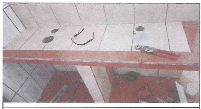
Foto 6: Hecha de mesas de cemento con azulejo para colocar lavamanos
