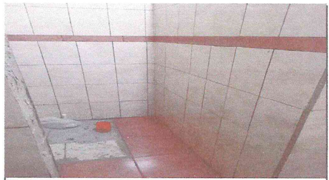
Foto 4: Colocación de azulejo en baño de mujeres
