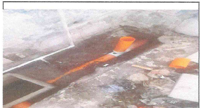
Foto 2: Cambio de Tuberia en baño de Mujeres
