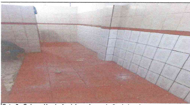
Foto 5: Colocación de Azulejo y piso en baño de hombres
